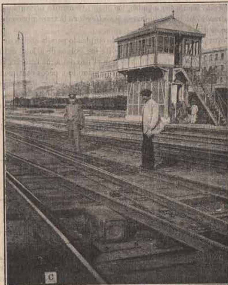
Fig. 16.--Vista de la caseta de enclavamiento.—En la parte inferior un motor de aguja y un comprobador C .
