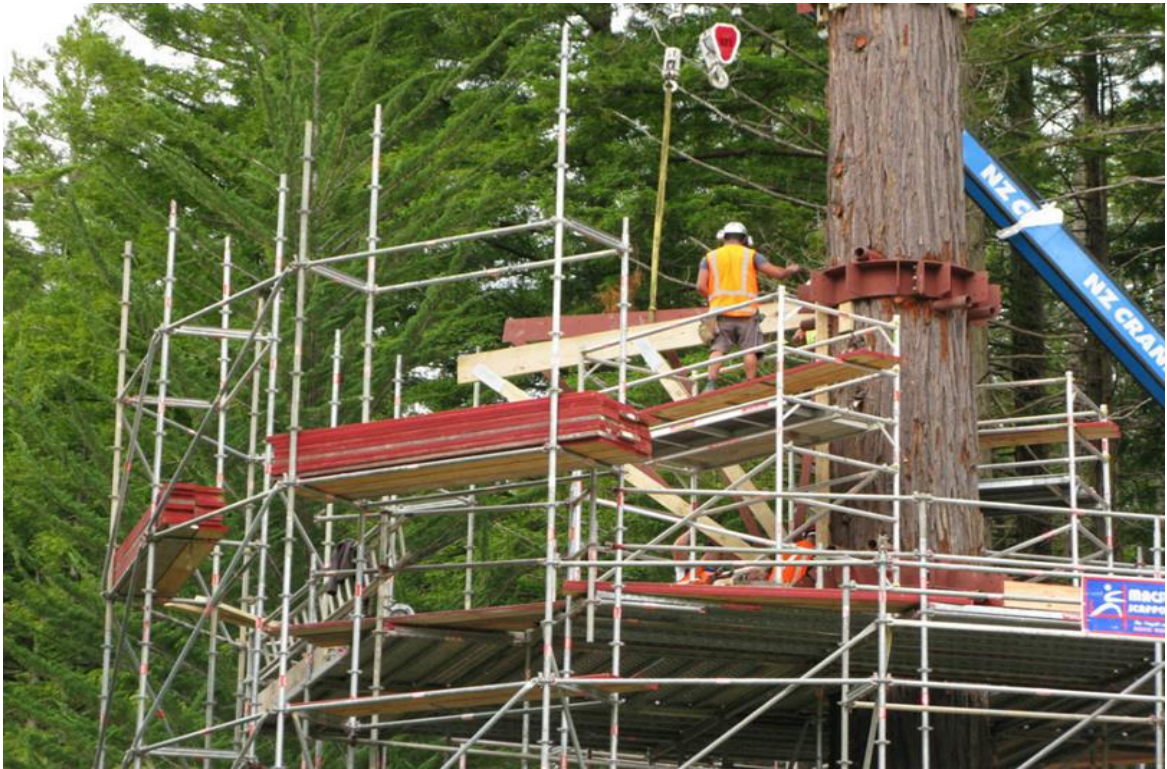
Slika 3.12 Pritrditev jeklene konstrukcije
