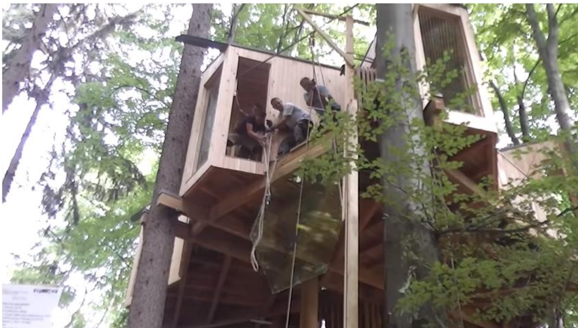
Slika 3.6 Vgradnja steklenih površin
