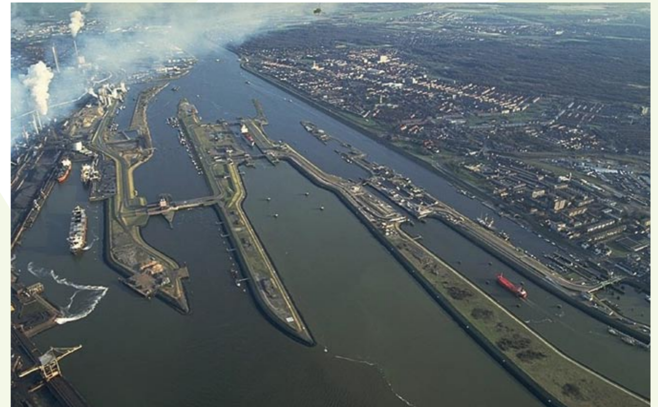
Figure 2.7.2 Port of IJmuiden, the Netherlands (Rijkswaterstaat)
