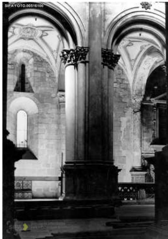
Figura 39: Colunas da nave central durante as obras de restauro dos inícios do século XX, onde ainda são visíveis os estuques que foram eliminados.
