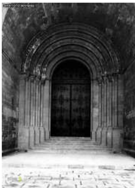
Figura 40: Portal da fachada principal depois das obras dos inícios do século XX.
