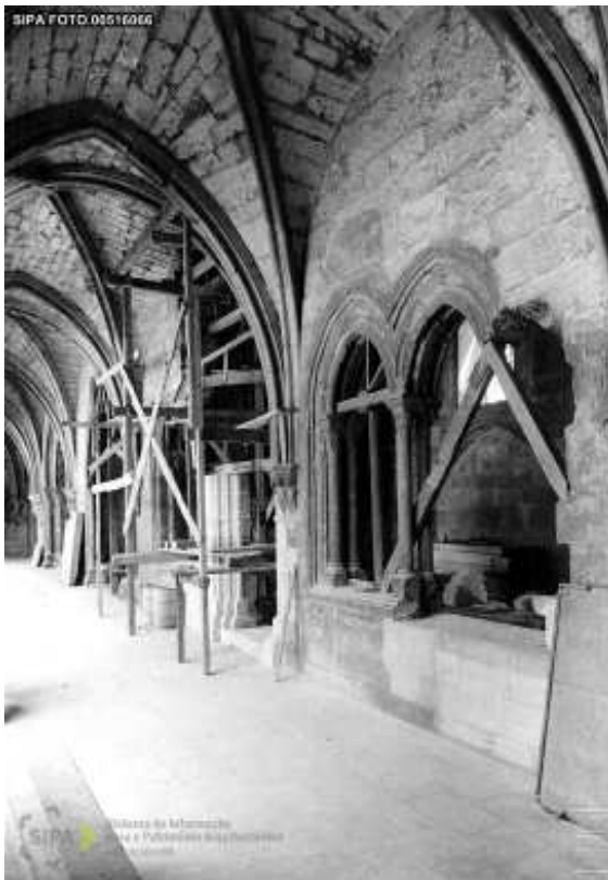
Figura 38: Reconstrução dos arcos ogivais do claustro, durante as intervenções dos inícios do século XX.
