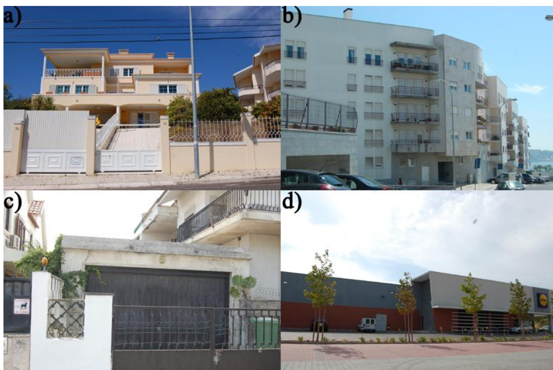
Figura 5.1 - Exemplos de edifícios: a) Habitação unifamiliar; b) Habitação multifamiliar; c) Anexo; d) Edifício de comércio/serviços
