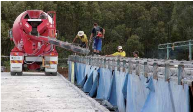
Pouring the concrete plats
