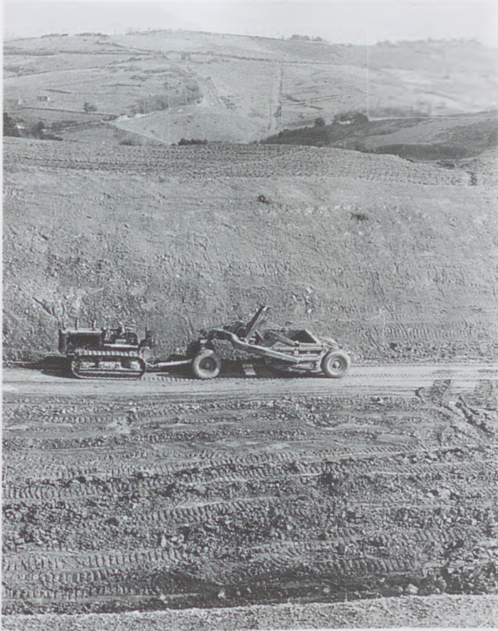
Hacıosman Bayırı'nda yol yapım çalışmaları. Alman Arkeoloji Enstitüsü Arşivi
