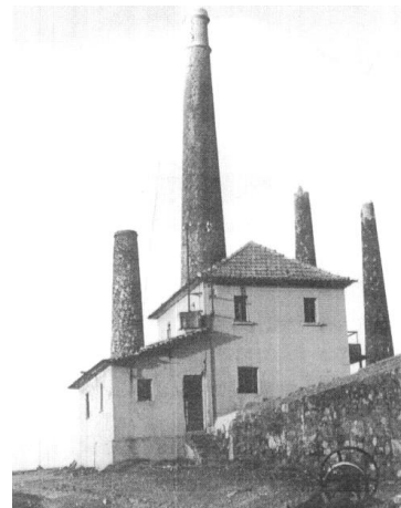
Figura 2.13 - Em primeiro plano a cobertura do guincho que se prolonga até ao poço (A) e perto das chaminés o edifício administrativo (B).
