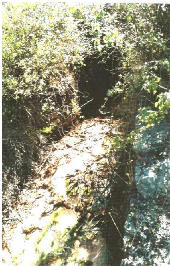
Figura 2.17 - A saída da galeria de esgoto da mina na actualidade (Moreno, 2000).
