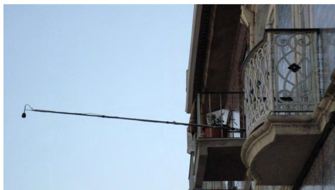
Figura 4.2 – Posicionamento do microfone na fachada do edifício.
