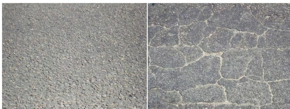
Figura 4.14 - Pavimento no ponto de medição P1 (esquerda) e pavimento degradado no ponto de medição P3 (direita).
