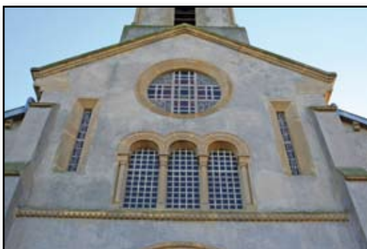
Villers-Stoncourt, baies néo-romanes de la façade
