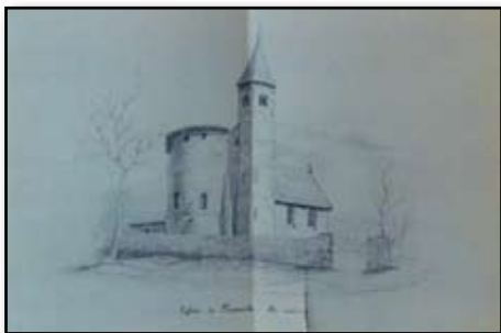
Noisseville, église paroissiale avant restauration, dessin Charles Gautiez
