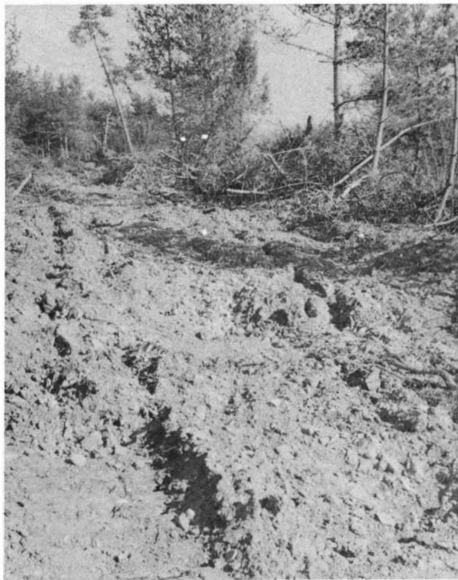
Photo 22. — Travaux sur terrains en pente. 3. Aspect de la banquette après sous-solage. Contrat F.F.N. de Bahours — S.C.I. du Gévaudan 1962. Photo R. S.B.
