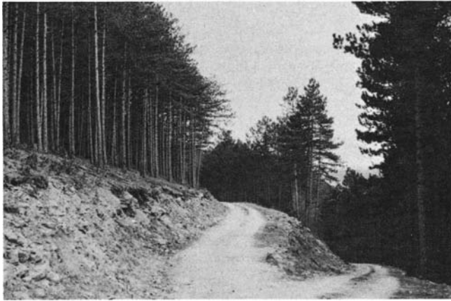
Photo 43. — Forêt domaniale de Mende. Nouvelle voie de vidange à travers les peuplements de Pin noir des versants de la vallée du Lot. Photo M.C.-C.R.P.F.
