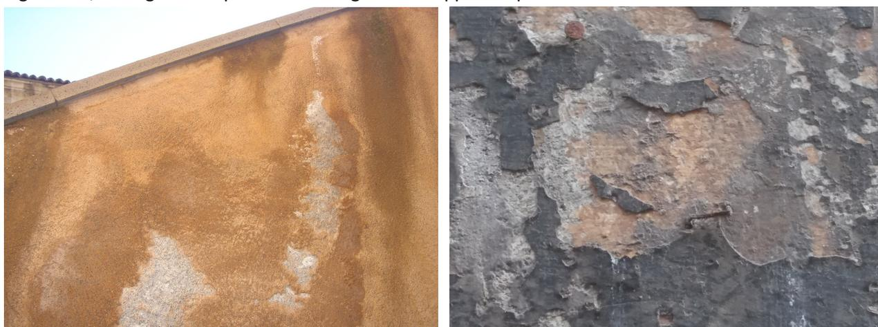
Figure 1-2 – esempi di degrado delle superfici intonacate
