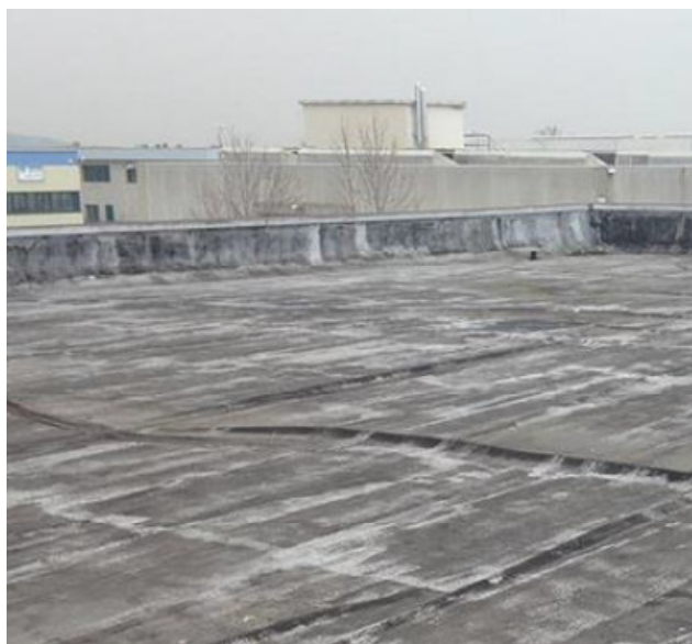
Figura 2 – condizioni di conservazione del manto impermeabile
