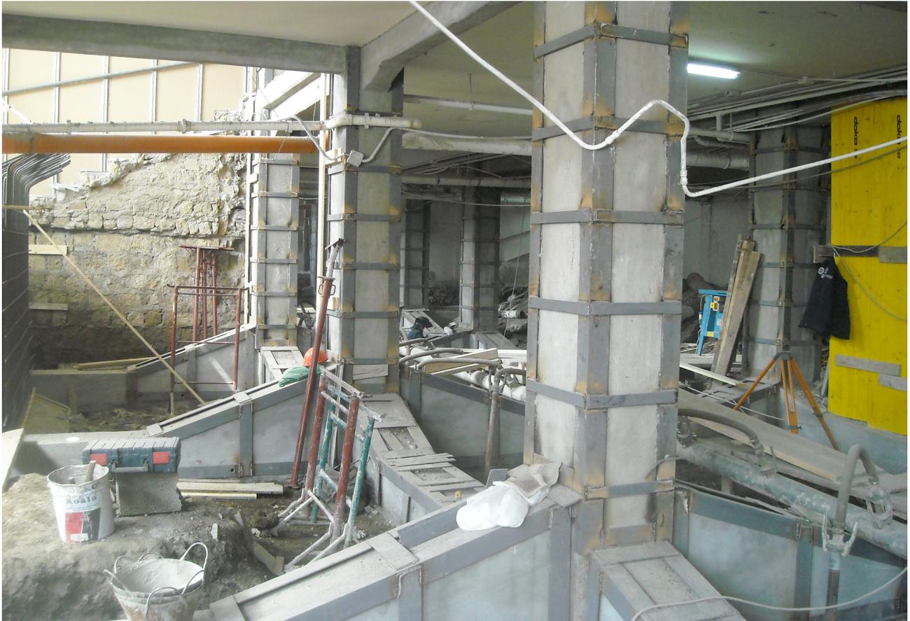
**Foto 3** – fase di consolidamento delle travi rovesce in fondazione
