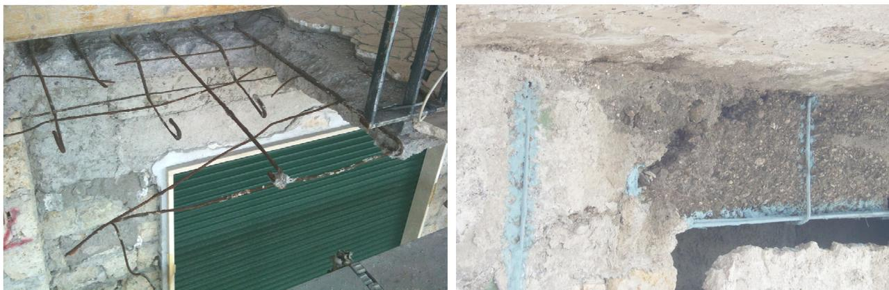
**Foto 1** – crollo parziale di una soletta a sbalzo all'atto della rimozione del pavimento
