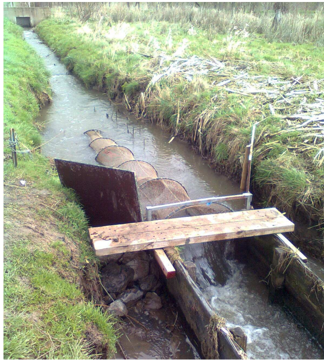
Figuur 3. Vangstconstructie op de visnevengeul ter hoogte van de Terbiestmolen aan de Zwalmbeek.
