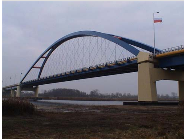
Figur 1.7 - Nettverksbuebru med skråstilte buer over Dziwna i Polen [7]
