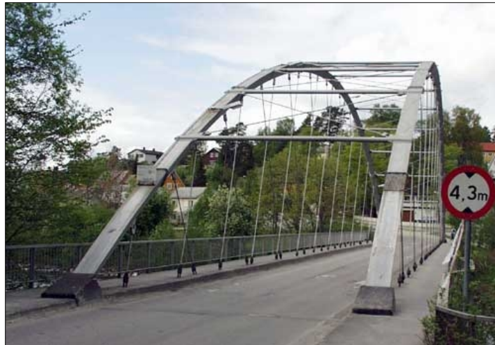
Figur 1.3 - Håkkadalsbrua over Steinkjernelva [2]
