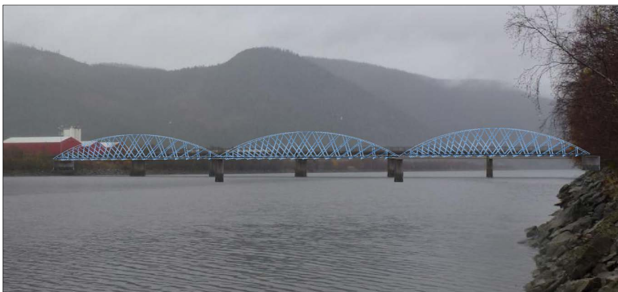
Figur 3.4 – Nettverksbuebrua med tre like spenn
