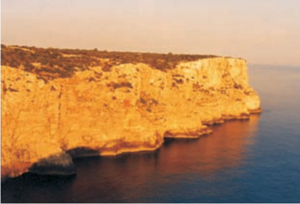
Figura 5 Ses Penyes d'Alaior, un acantilado que supera los 50 m
