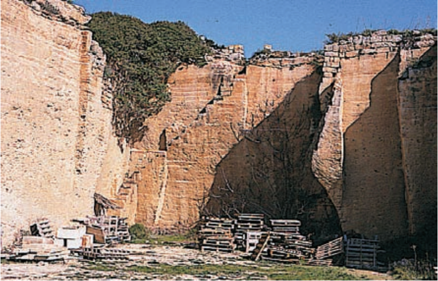
Figura 2 Aspecto general de la cantera de marès poco después del abandono de su explotación
