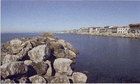
Fig. 6. Estructuras de defensa a Marina di Pisa. Fig. 6. Defence structures at Marina di Pisa.
