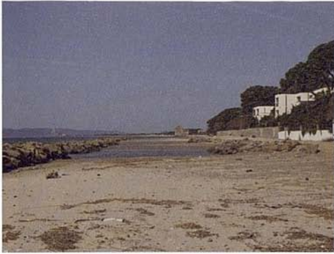
Fig. 8. Estructuras de defensa en la playa de Follonica.
