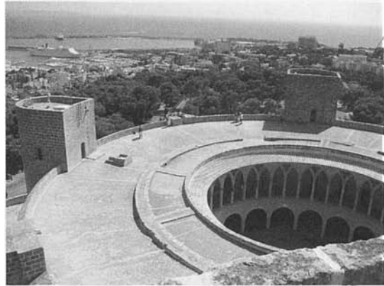
Vista sobre el castell i el port des de la torre de l'Homenatge.
