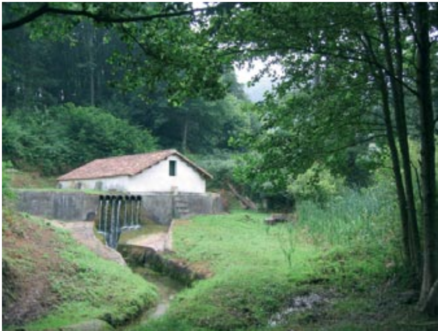
Figura 8. Fuente La Ruxidora con la caseta de captación, el aliviadero y la estación de afloros.
