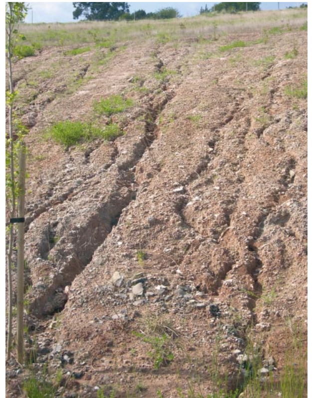
Figura 6. Acarcavamientos producidos por arroyada concentrada. Los fragmentos que se observan corresponden al deterioro de los niveles yesíferos.
