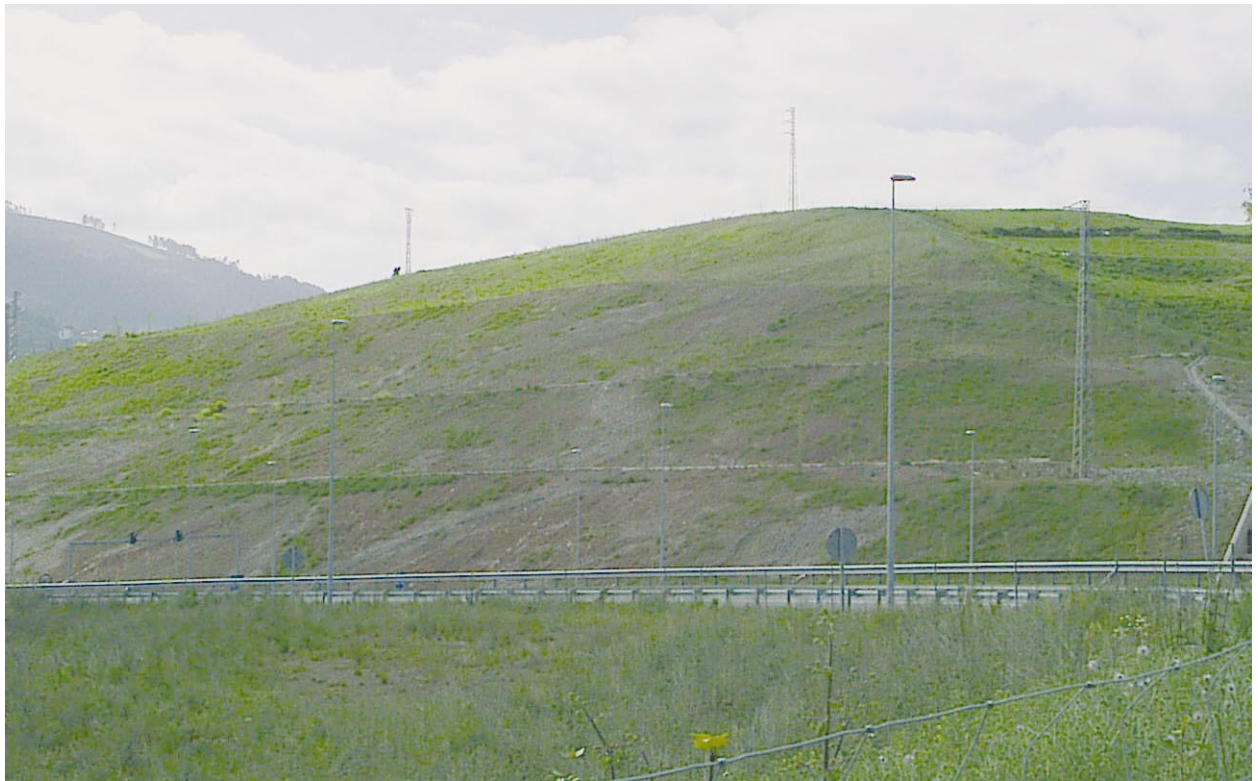
Figura 5. Talud con bermas a varios niveles en las cercanías del paso inferior bajo la ría, margen derecho, en dirección a Villaviciosa (A-8, pk 364).
