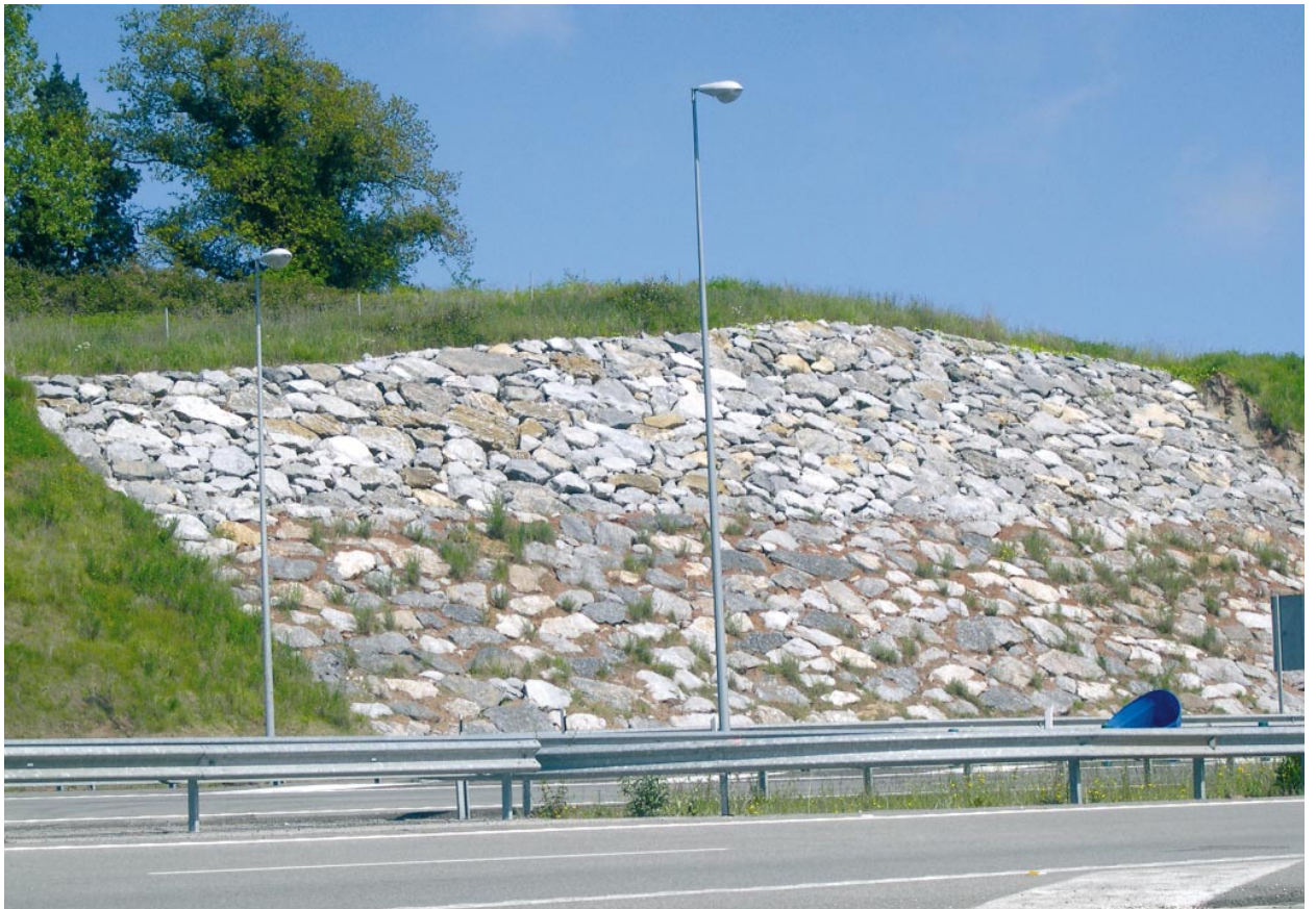
Figura 8. Escollera de revestimiento en la Autovía A-64.
