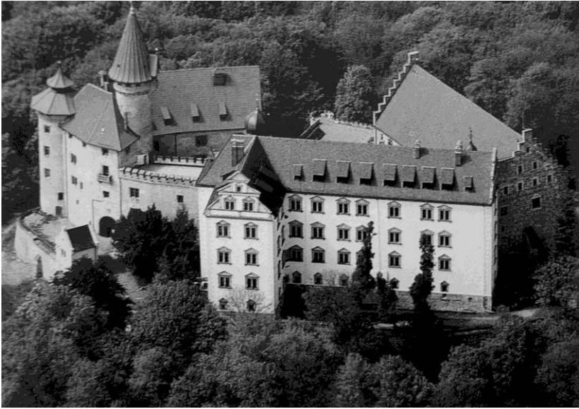
Abb. 4: Heldburg, Kreis Hildburghausen, Thüringen, Ansicht von Südosten
