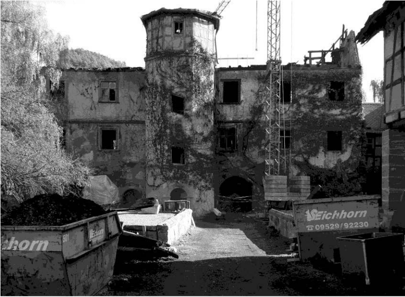
Abb. 10: Ebelsbach, Ansicht von Westen mit Treppenturm
