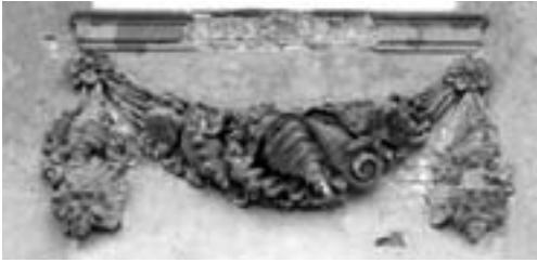
8. Zamek joannitów w Słońsku. fragment detalu architektonicznego, stan 2008
