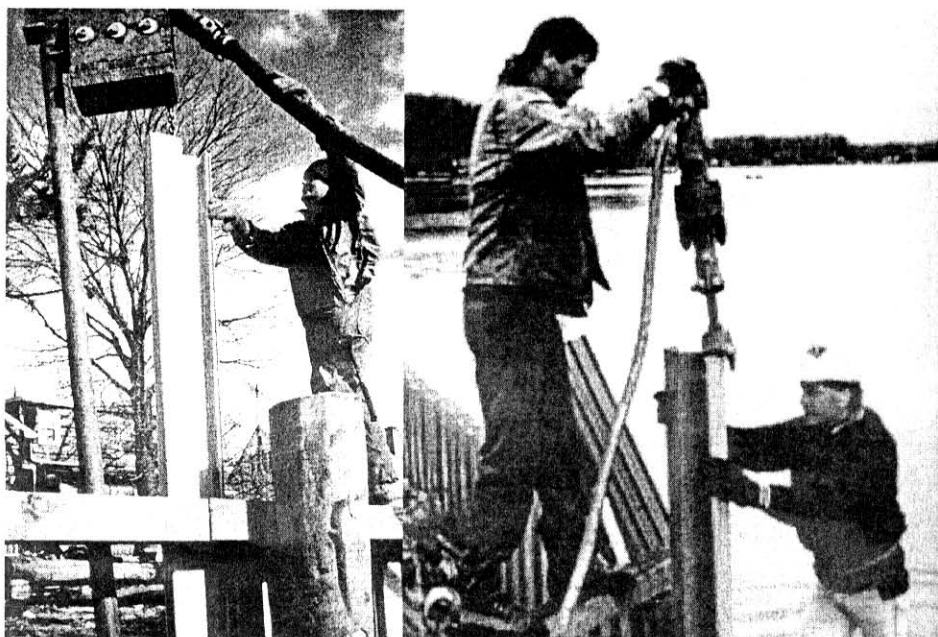
Rys. 3 Montaż grodziec C_LOC przy wykorzystaniu wibromłota
