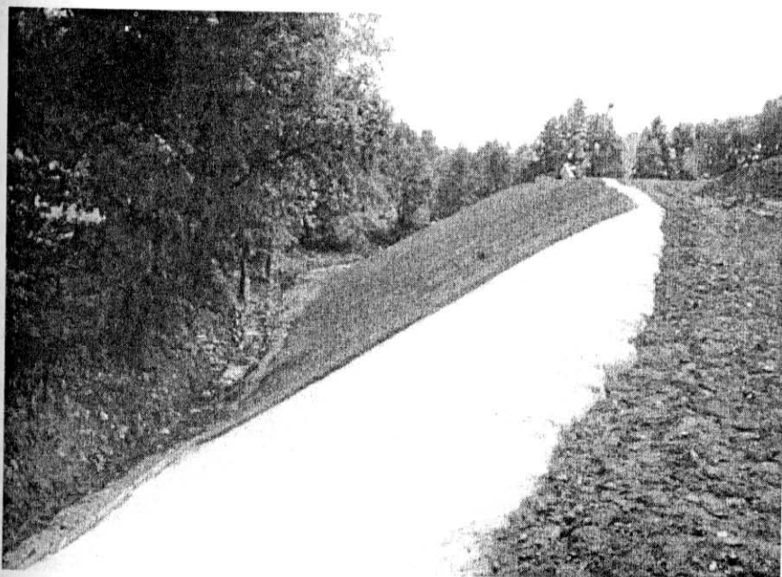
Rys. 2 Układanie warstwy ochronnej na rozłożonej macie bentonitowej
