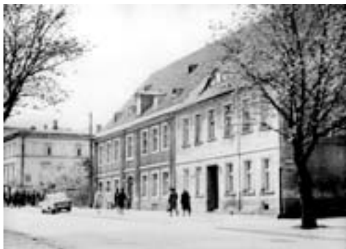
Powiatowa Biblioteka Publiczna w Zielonej Górze przy ul. Jedności Robotniczej 45.
