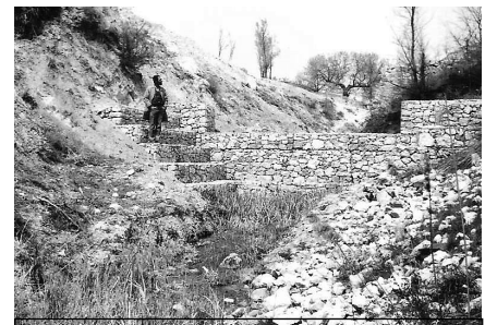
Ferdi Baal inspecteert een geulbeteugelingswerk
