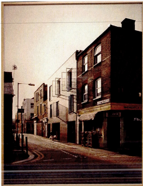
Figure B.6 Sous-unité grande photographie de la rue T3_PHE2
