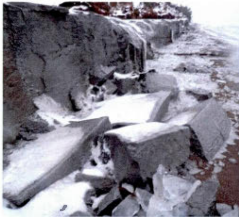
Figure 4. 54 Effondrement en blocs provoqué par la cryoclastie.
