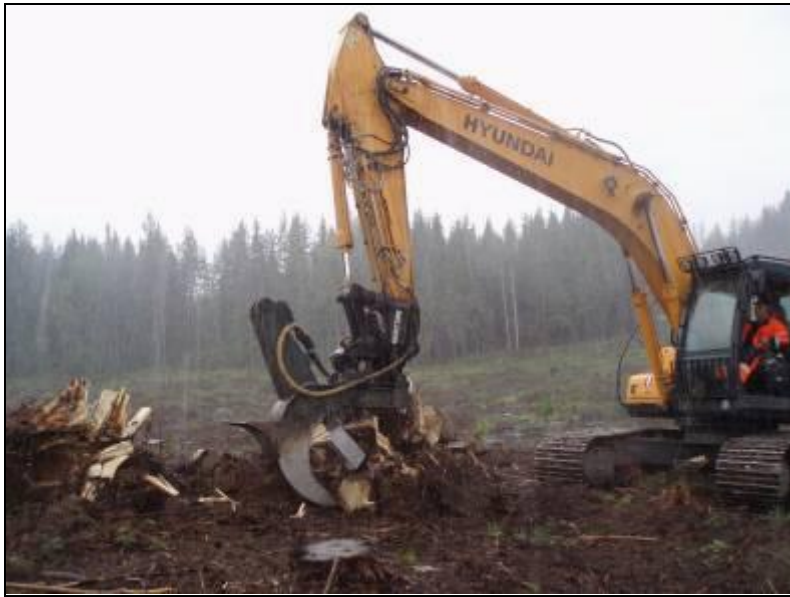
Kuva 11. Kantojen nostoa kaivukoneeseen kiinnitetyllä kantoharvesterilla (kuva M. Ruokolainen).
