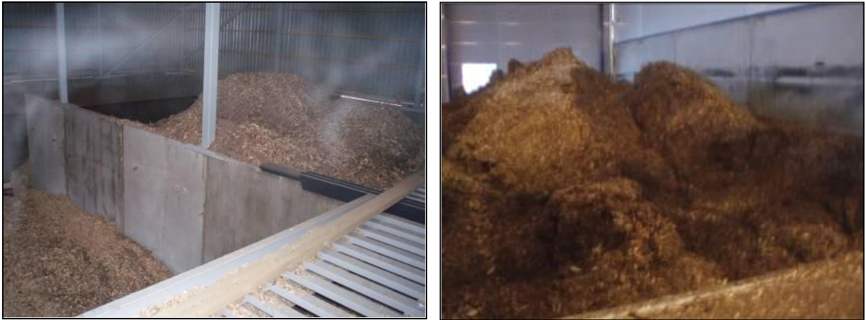
Kuva 8. Hakkeen varastointia lämpökeskuksessa (kuvat M. Ruokolainen).
