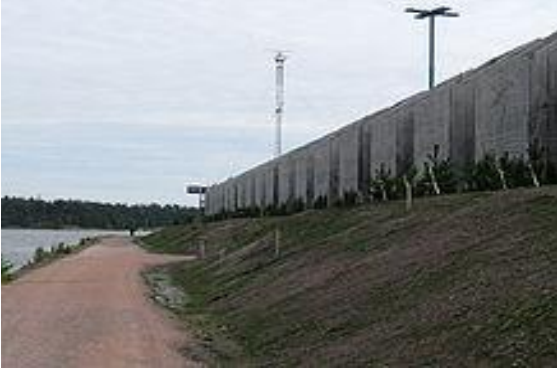
Kuva 8. Melumuuri Vuosaaren satamassa
