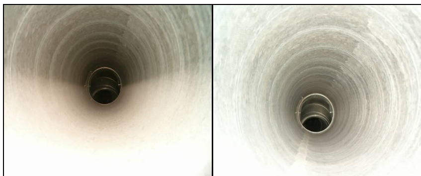
Kuva 15 (a), Tuloilmakanava ennen Kuva 15 (b), Tuloilmakanava puhdistuksen jälkeen
