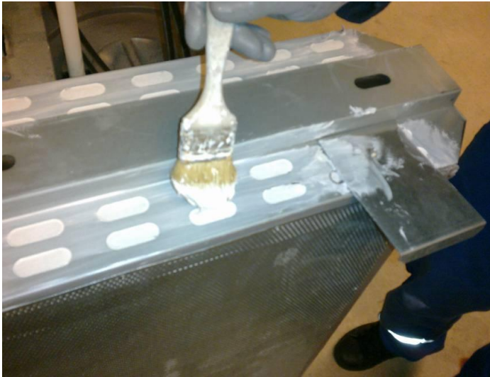
Kuva 13. Äänenvaimentimenavoimen mineraalivillapinnan kapselointi.
