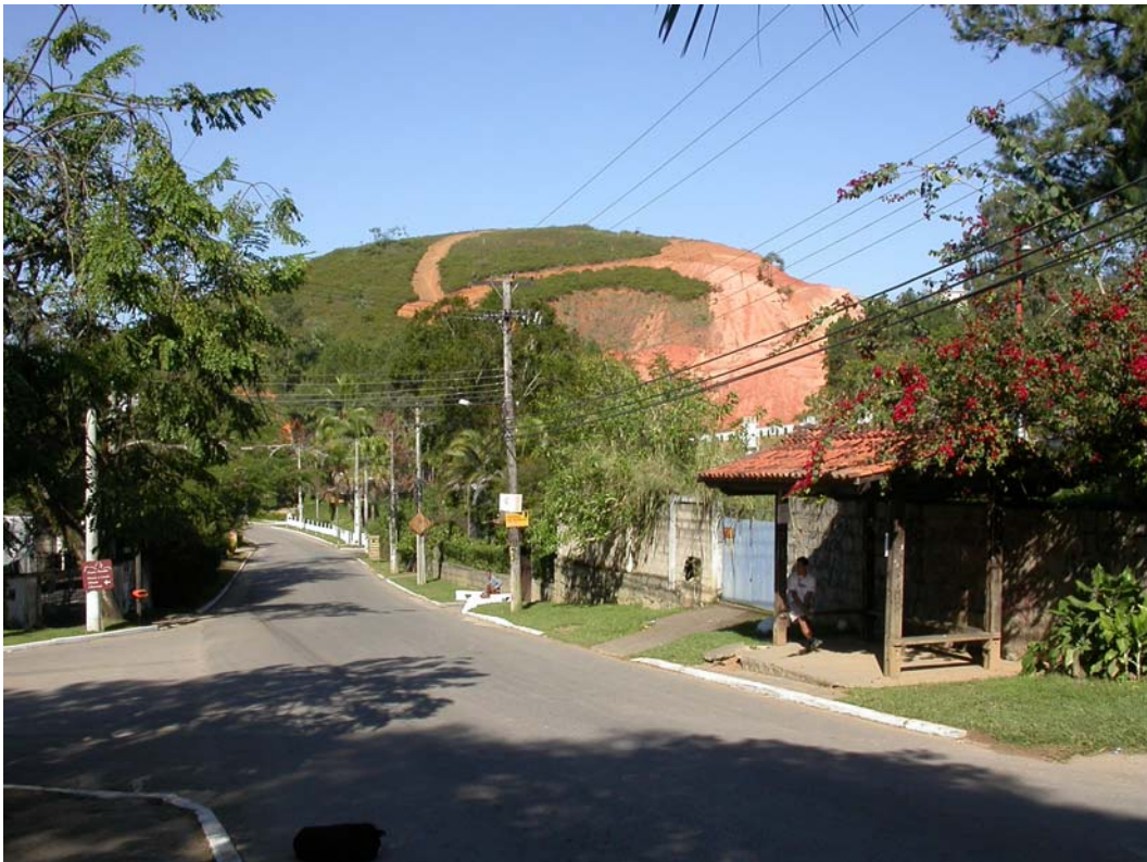
Kuva 88. Maa-ainesten siirtoa Penedon keskustassa, Suomi-klubin suunnasta katsottuna.
