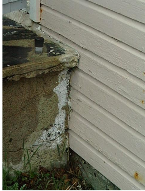
Kuva 6. Kellarinseinän sisäpuolinen koolaus Kuva 7. Betoniporras puuseinää vasten
