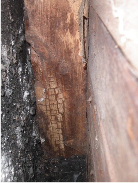
Kuva 6. Kellarinseinän sisäpuolinen koolaus Kuva 7. Betoniporras puuseinää vasten
