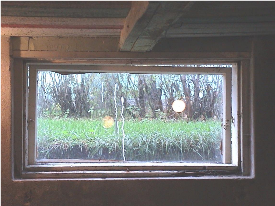
Kuva 5. Kellarin ikkuna pihanurmikon alapuolella
