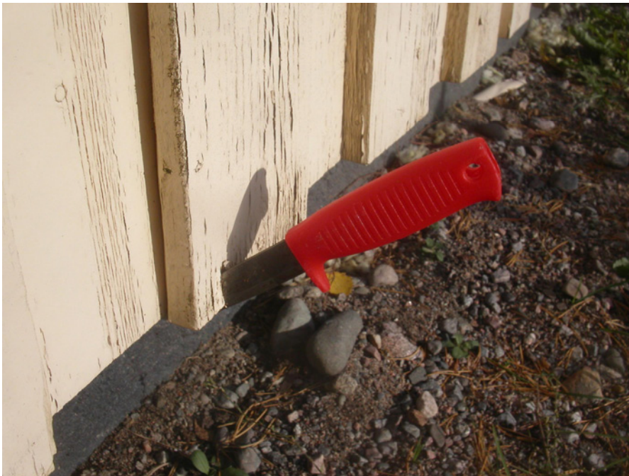
Kuva 10. Lahonnutta julkisivulaudoitusta
