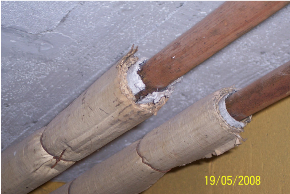
Kuva 16. Jälleenrakennuskauden pientaloissa on käytetty mm. asbestipitoisia putkieristeitä
