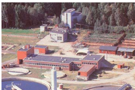
Riihimäen kaupungin jätevedenpuhdistamo.
