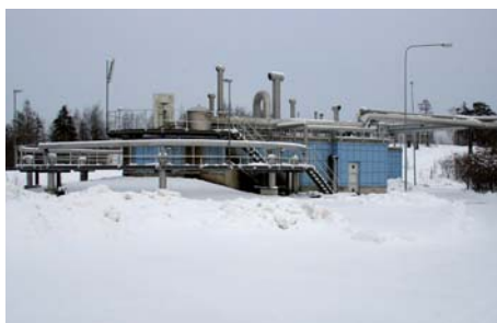
Viikinmäen laitoksen maanpäällisiä rakenteita.
