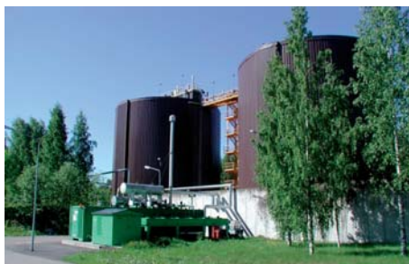
Suomenojan biokaasureaktorit ja kaasumoottori.
