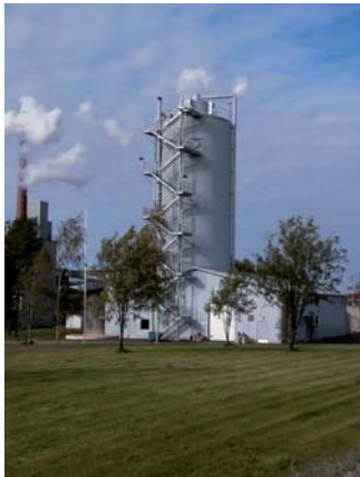
Apetit Suomi Oy:n anaerobilaitos.
