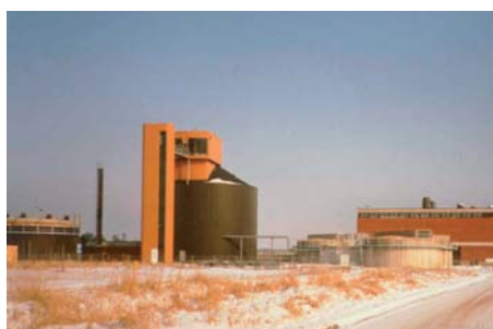
Salon kaupungin jätevedenpuhdistamo.
