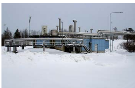
Viikinmäen laitoksen maanpäällisiä rakenteita.
