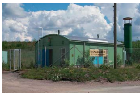
Seutulän kaatopaikan pumppaamo.
