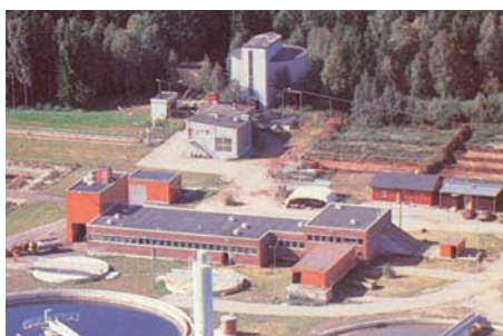
Riihimäen kaupungin jätevedenpuhdistamo.
