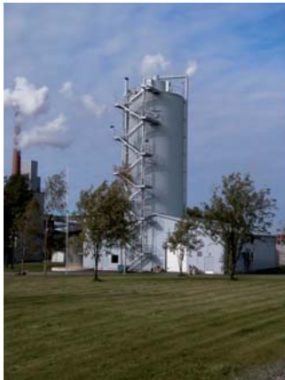
Apetit Suomi Oy:n anaerobilaitos.
