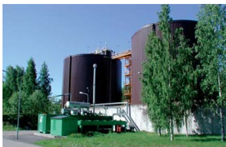
Suomenojan biokaasureaktorit ja kaasumoottori.
