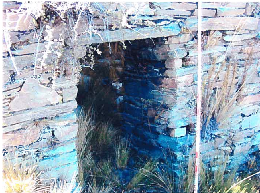
Photo 114. Profil d'une porte caractérisée par la méthode de construction de superposition de dalles du site # 42 (Pampan I) de Singa.
