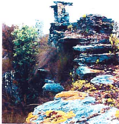
Photo 53. Vue de la partie supérieure d'une muraille exhibant, d'une part, des parapets construits par la technique de pachillas , et d'autre part, des pierres saillantes servant d'escaliers.
