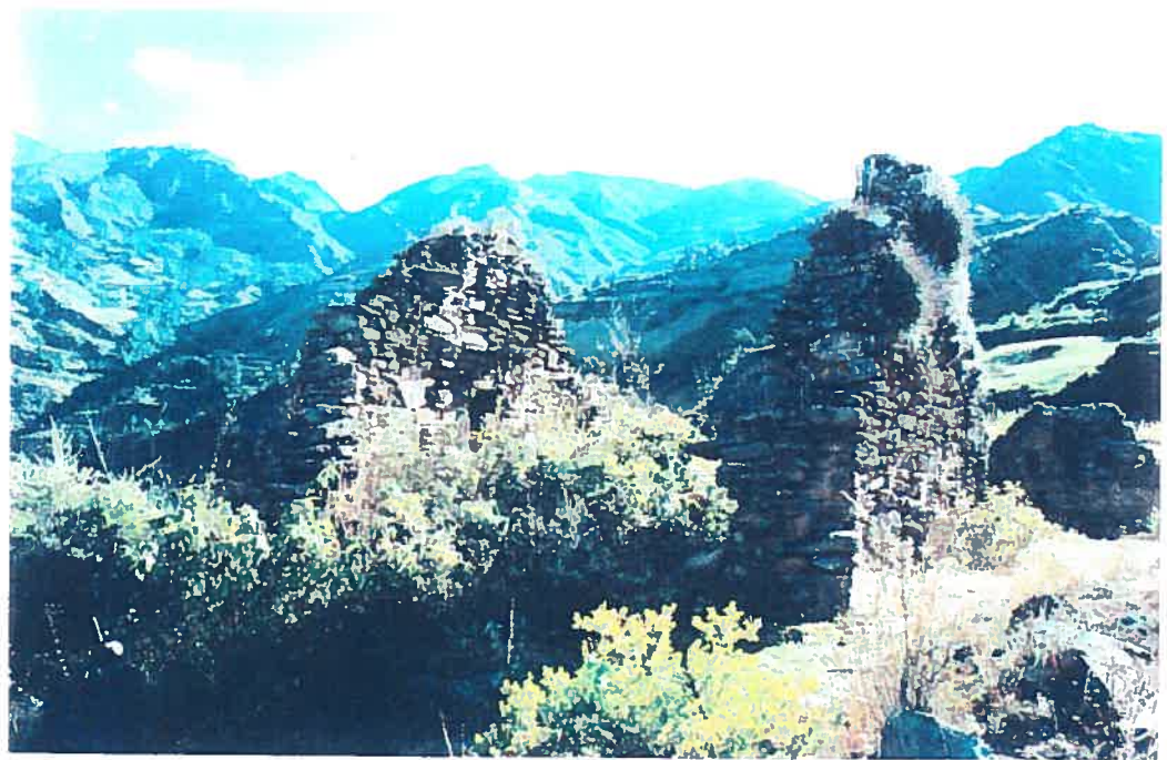
Photo 70. Structure de style Inca du site # 51 (Numawilca).
