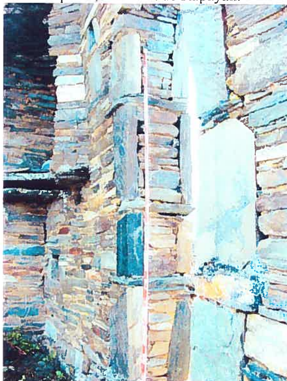
Photo 24. Profil de la porte d'entrée principale d'une habitation présentant des pachillas , secteur III de Rapayan.
