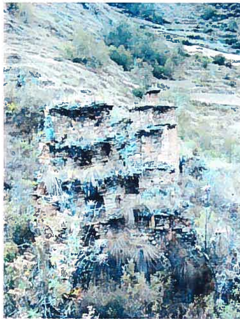
Photo 96. Edifices à étages multiples à niches externes du site # 33 de Gantumarca.
