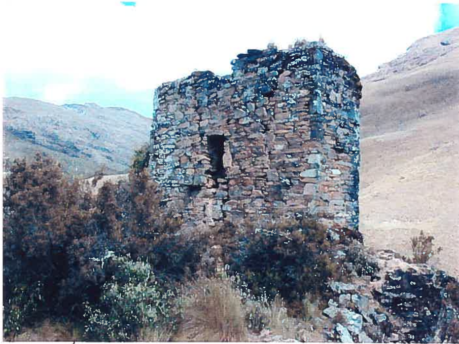
Photo 88. Édifice à étages multiples du site DCC # 8 (Ichun) de Huacchis.
