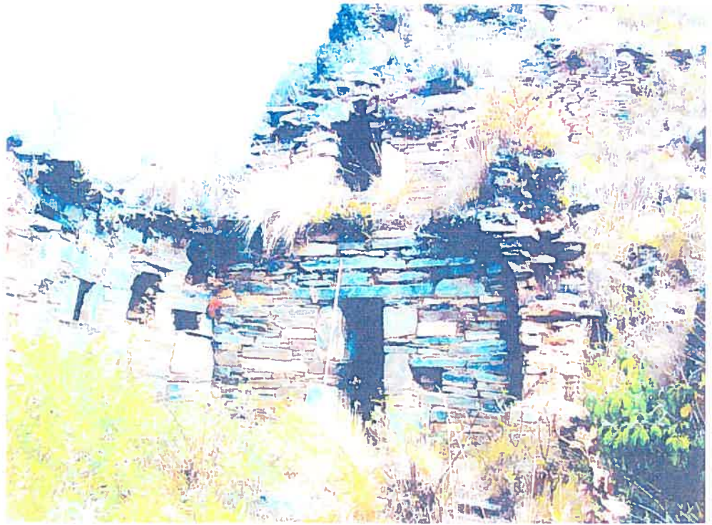
Photo 29. Habitation présentant un mur arrière en pignon ayant accueilli un second étage sur lequel a été érigé un double de la seconde pièce du premier niveau, secteur III de Rapayan.
