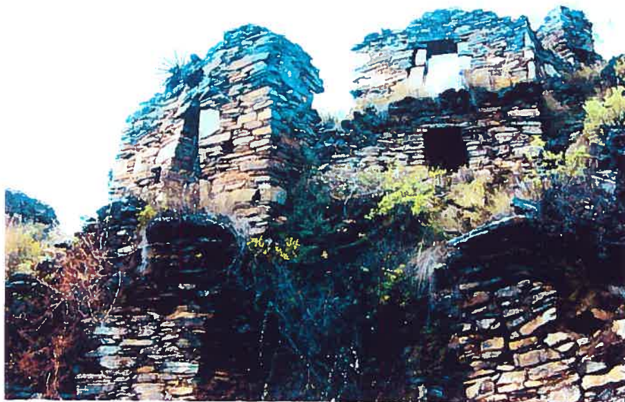
Photo 16. Exemple de maisons dont les murs arrières servent de mur de soutien aux habitations de la terrasse supérieure, Rapayan, secteur IV.
