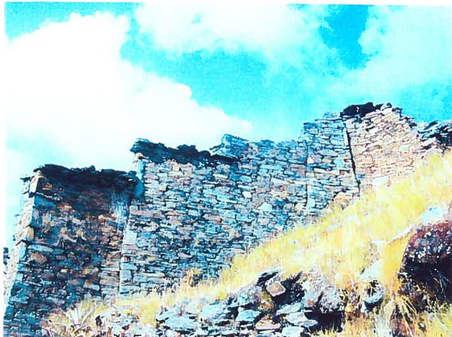
Photo 59. Détail de la technique de construction de la muraille du complexe B du site # 13 (Tactabamba II).
