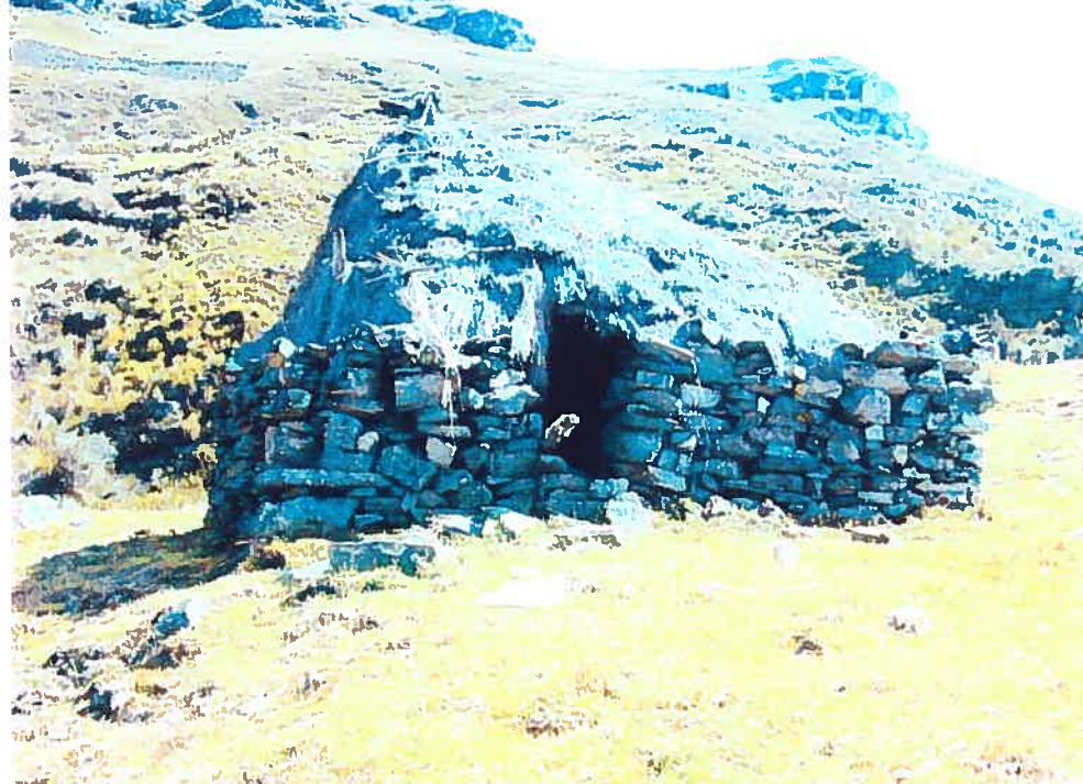
Photo 28. Maisonnée actuelle présentant une toiture de bois recouvert d' ichu érigée dans la puna à l'époque de la récolte de tubercules.
