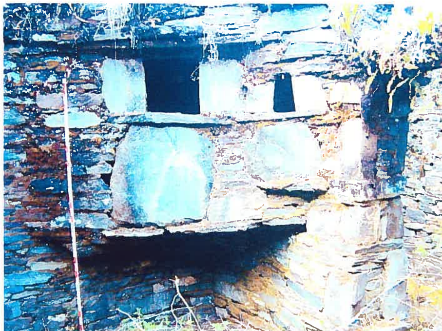
Photo 27. Vu d'une corniche intacte située dans le coin interne gauche d'une habitation présentant deux pierres verticales et deux fenêtres, secteur III de Rapayan.
