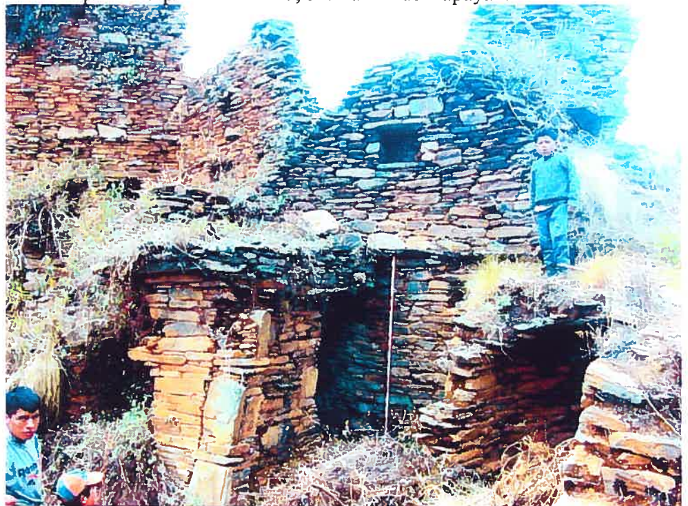
Photo 30. Habitation présentant un mur arrière en pignon ayant jadis accueilli un second étage. Des pierres saillantes localisées au pied du pignon servaient à joindre des dalles au toit de la seconde pièce. Ce dernier servait également de plancher du deuxième étage, secteur I de Rapayan.
