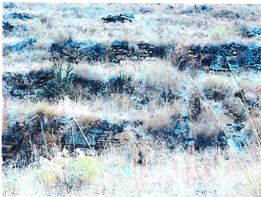
Photo 94. Détail des murs de soutien des terrasses agricoles dans la zone de Gantumarca.
