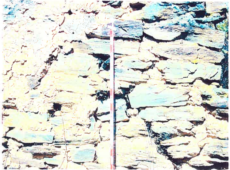
Photo 39. Construction rectangulaire dans la forêt d'eucalyptus illustrant la technique de construction (pierres grossières, épaisse couche de mortier et enlucido ), Rapayan.
