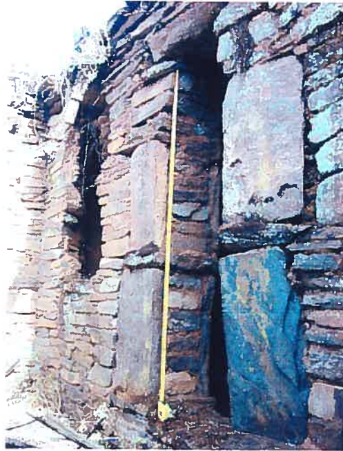
Photo 65. Porte arrière d'une maisonnée du secteur I de Porvenir (site # 30) construite par la méthode de pachillas .
