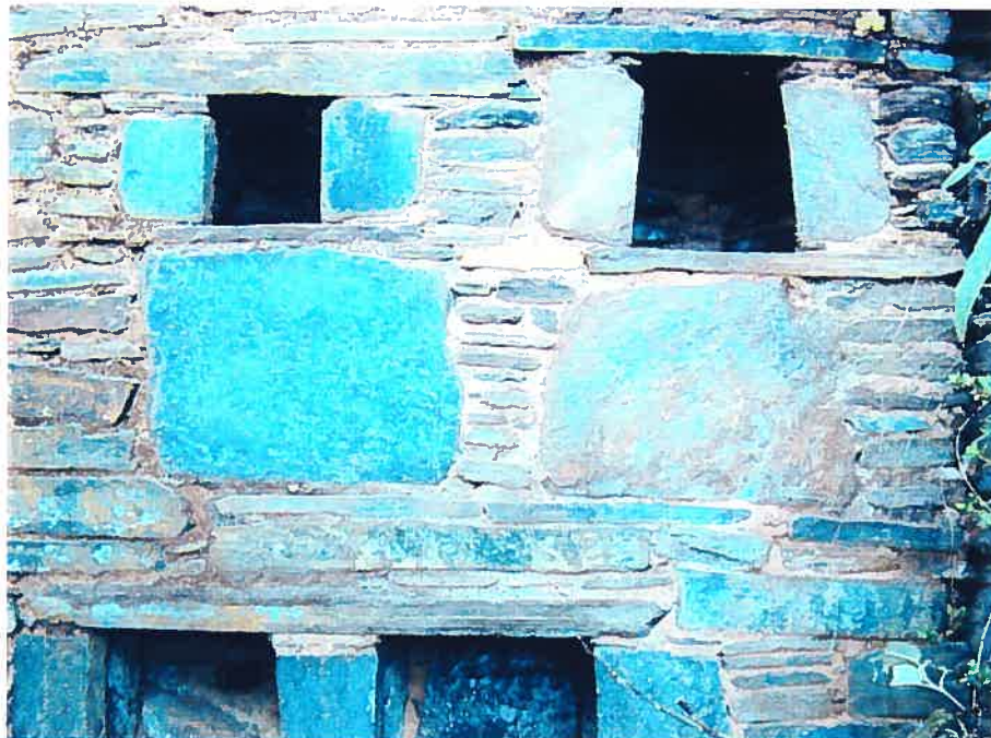
Photo 97. Mur latéral d'une habitation flanqué de niches semi-ouvertes du site # 33 illustrant la finesse de l'architecture de Gantumarca.
