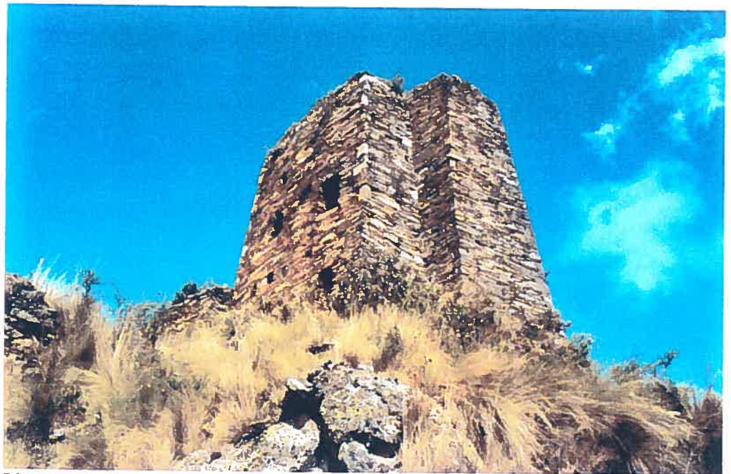
Photo 122. Vue de profil des « tours jumelles » du site # 43 (Wata) de Singa.
