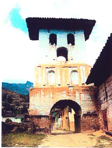
Photo 13. Clocher de l'église catholique de Rapayan érigée à la fin du 17 ième siècle. L'enduit qui le recouvre est identique à la chullpa type B. Il est composé d'argile et de pierres calcaires broyées.
