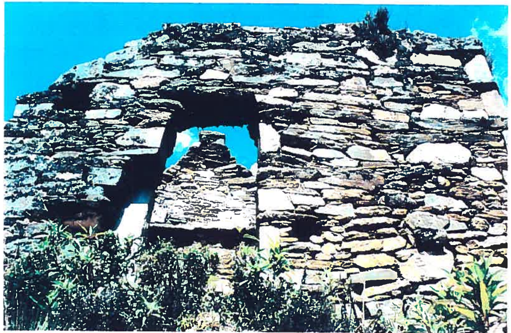
Photo 72. Façade externe d'une structure d'habitation du site # 47 (Yuying) de Yanas illustrant une finition moins recherchée qu'à Rapayan. Notez le mur arrière en pignon.
