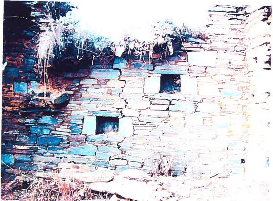
Photo 17. Mur latéral interne d'une habitation illustrant les techniques de construction par superposition de dalles de pierres calcaires et par pachillas . Les petites niches ornant la paroi sont de type ouvert, secteur II Rapayan.
