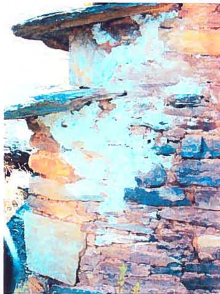
Photo 12. Enduit ( enlucido ) composé d'un mélange d'argile et de pierres calcaires broyées recouvrant l'extérieur de la chullpa type B et des petites chullpas semi-circulaires, secteur I de Rapayan
