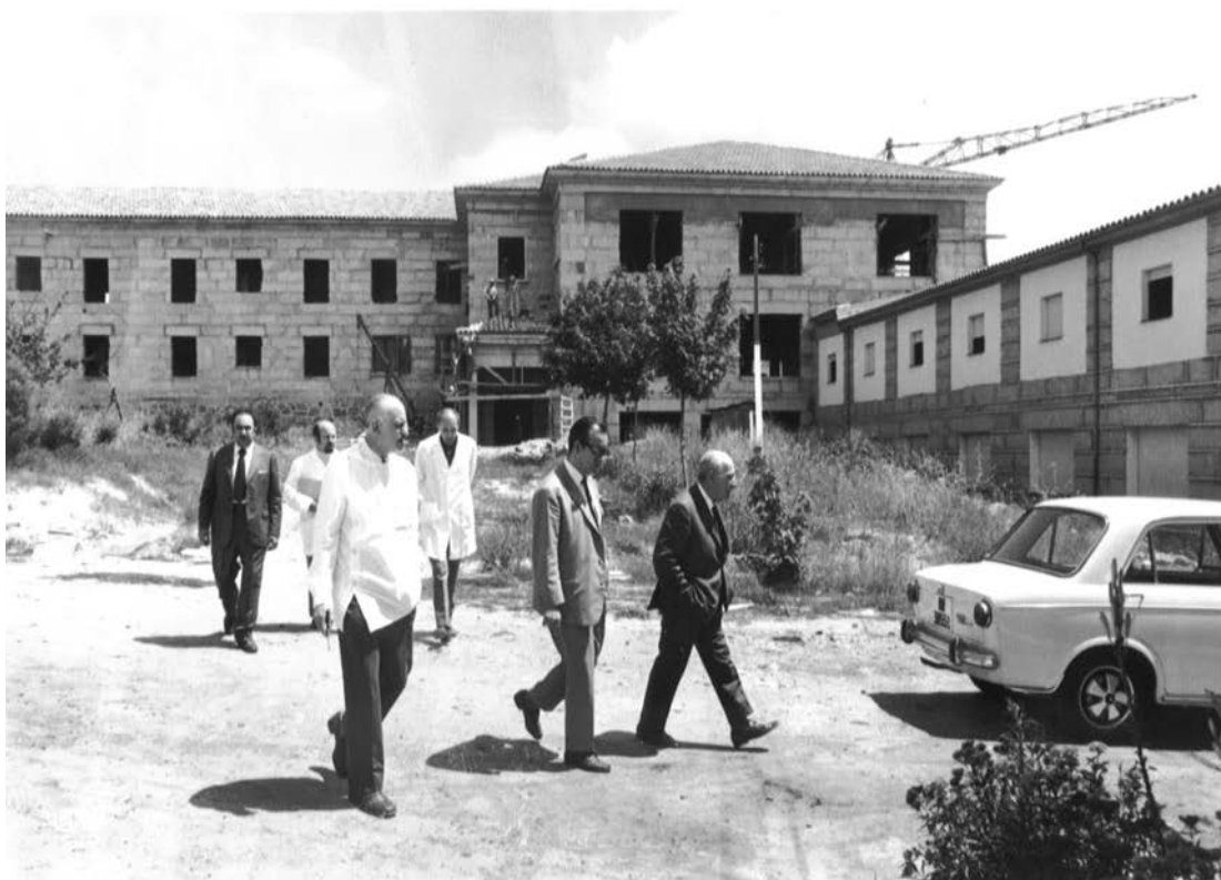
Ilustración 7. Cabaleiro Goás (en primer plano con batín) y a su derecha en la foto el Dr. Serigó Segarra (secretario General PANAP) en visita de obras en Toén, finales años 60.
