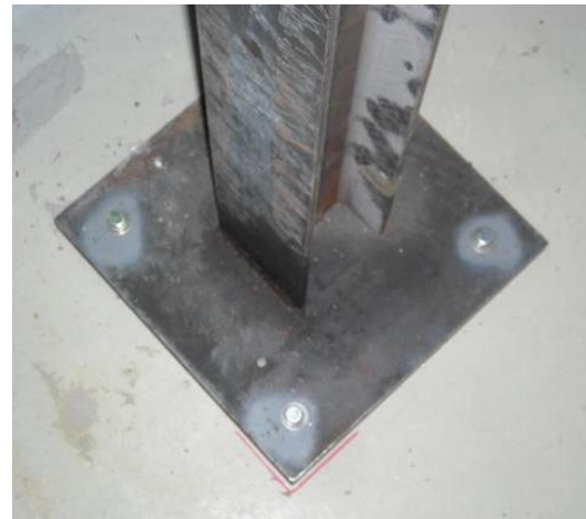
(d) Column-base joint.
