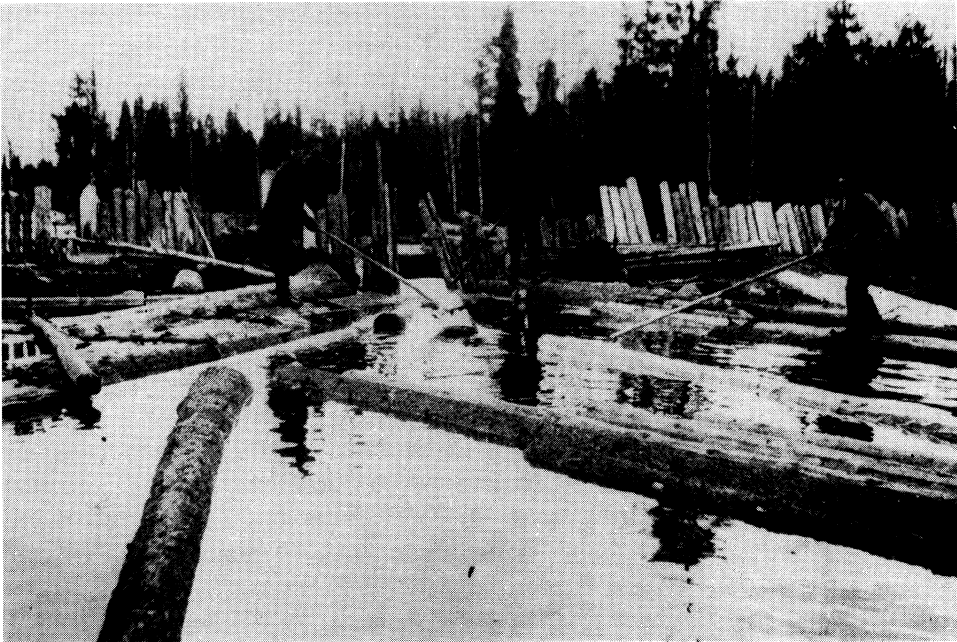
Veden määrän säätelyä ja uittettävien puiden ohjaamiseksi rakennettiin erilaisia uittolaitteita. Padot ovat niistä tavallisimpia uittokourujen ja puomitusten ohella. Kuvassa hirsipato eli tammi Sotkamon Tiplasjoella, missä sen kuvasi Aimo Suomalainen vuonna 1925 (Kainuun museon kuva-arkisto).
