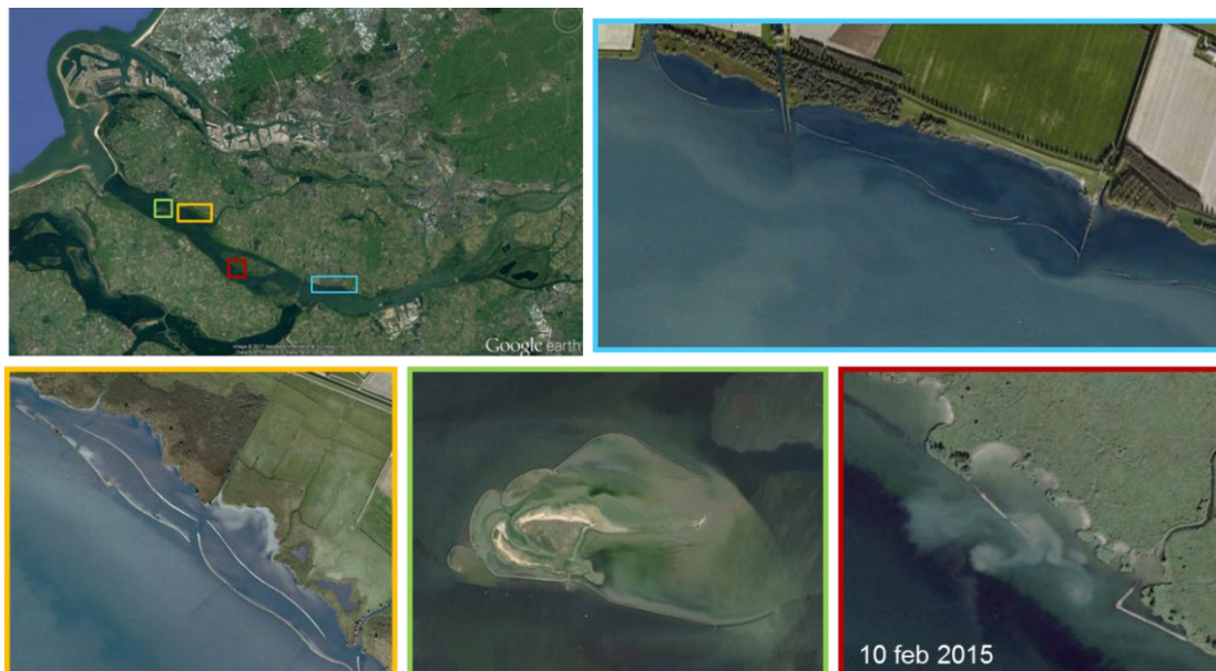
Figuur 23 Google Earth © beelden van de vooroeverscherming op diverse locaties. Voor het zuiden van Tiengemeten (rode rechthoek), is op de satellietbeelden te zien dat een deel van de vooroeverscherming verzakt of verdwenen is en dat oevererosie nog steeds plaats kan vinden (wolken van sediment te zien).
