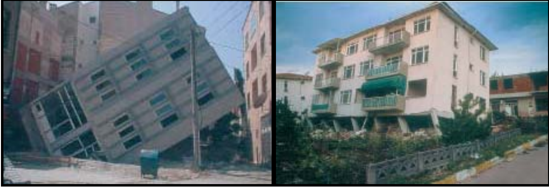
Şekil 2 1999 Depremlerinde Yumuşak Kat Oluşumu (7)
