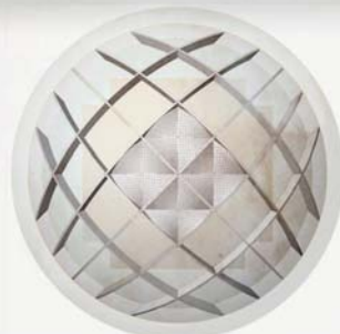
10 Cerramiento de bóvedas parabólico hiperbólicas (módulo 1) En los cuadriláteros resultantes entre los arcos, se coloca un cerramiento formado por bóvedas parabólico hiperbólicas
