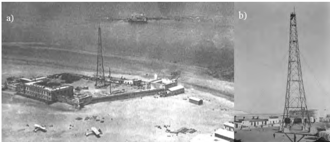
Figura 3.3: a) Vista aérea (ca. 1928) de las instalaciones militares españolas en Villa Bens (Franja de Cabo Juby), hoy Tarfaya, donde se aprecia la torre metálica de 60 m de altura usada en la observación para el enlace geodésico de 1927. La torre estaba montada en el fuerte militar que protegía el aeródromo. España ocupó esta parte del Sahara Occidental en 1916 para facilitar la logística de comunicaciones aéreas con Canarias ( Martínez Milán, 2007 ). Desde 1958 están bajo la administración de Marruecos. (Fotografía tomada de una tarjeta postal de la época). b) Detalle del montaje de la torre en el recinto que protegía el fuerte. Sobre la azotea del fuerte, a 12 m de altura, se realizó una determinación astronómica de coordenadas. El enlace angular se realizó en observación excéntrica por intersección inversa desde Fuerteventura ( Gil Montaner, 1929b ) usando un proyector AGA de luz Dalen cedido por el Servicio Central de Señales Marítimas, montado éste sobre la torre. La torre fue construida y transportada desde Barcelona, siendo desmontada en los años siguientes para permitir espacio en las ampliaciones posteriores de las instalaciones (fotografía de F. Gil Montaner, Archivo Histórico del IGN, sig. C-770).
