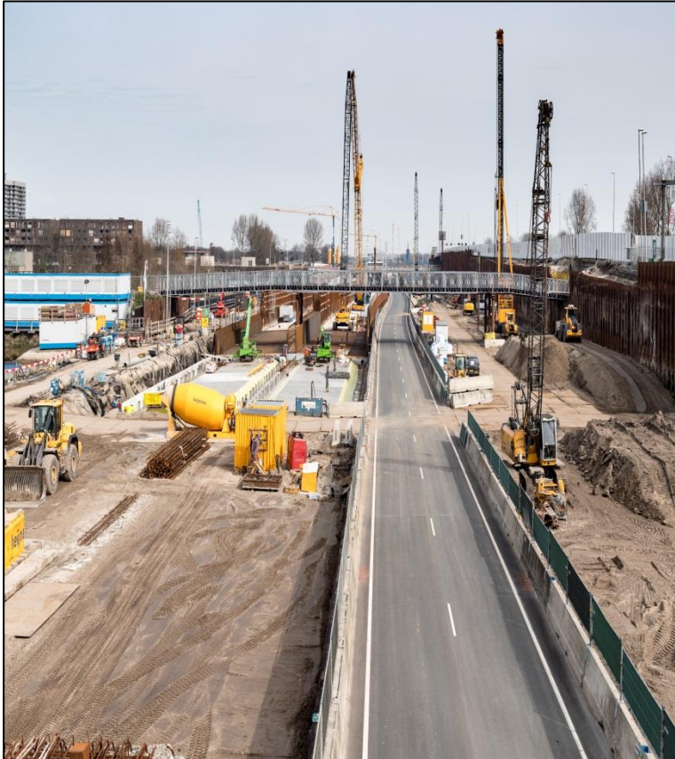
Foto 4. Verbreding A9 Gaasperdammerweg (Foto: Rijkswaterstaat)
