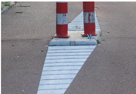
Figuur 5: De ribbelmarkering van Heijmans.
