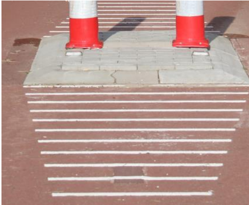
Figuur 7: De ribbelmarkering te Barneveld.
