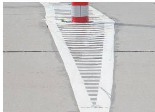
Figuur 6: De ribbelmarkering van VelopA.
