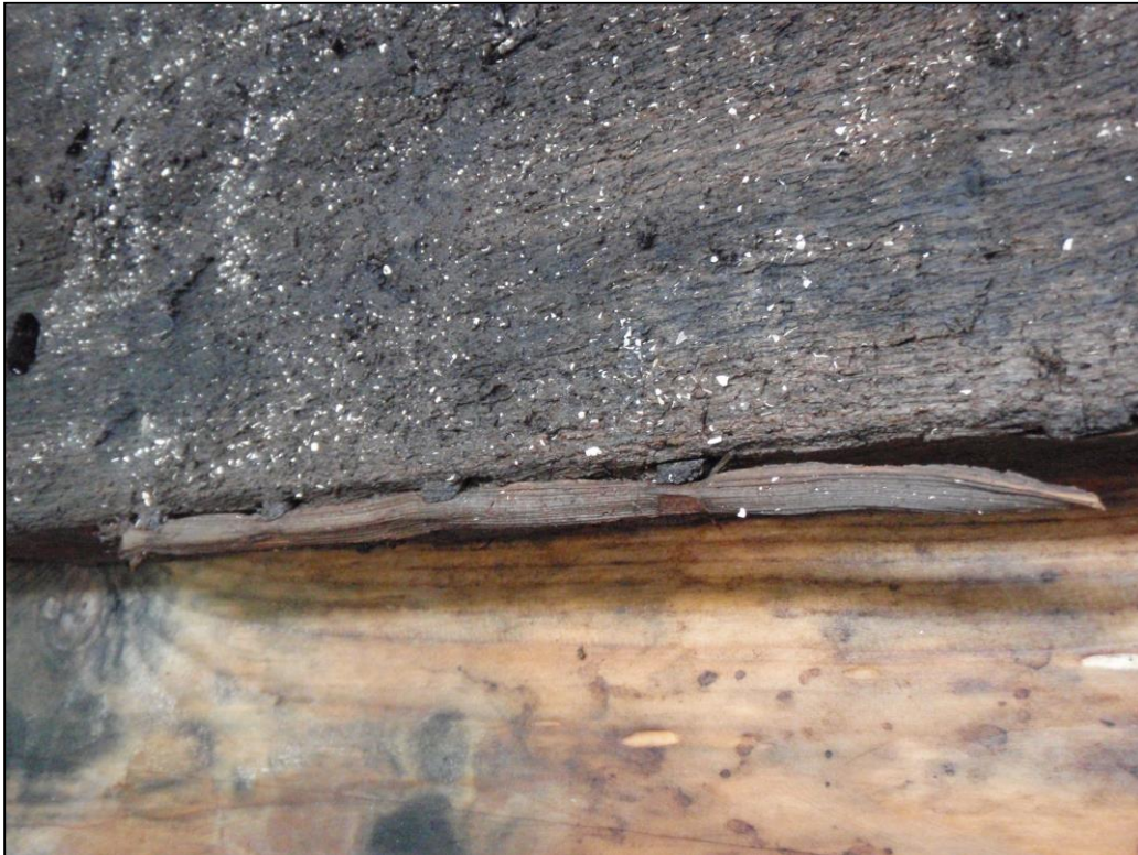
Fig. 36. Moslat met prikken in plank GG/BB-1 (Foto: J.P.F.Verweij, GIA).
