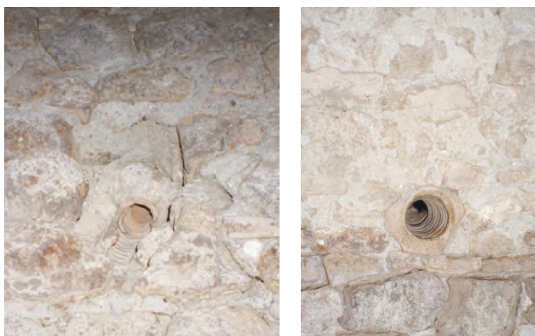
Figuur 20 en 20a: Rocca di Ostia, Uiteinden van twee terracotta leidingen die op verschillende hoogten in de muur zijn aangebracht (Foto's oktober 1999)
