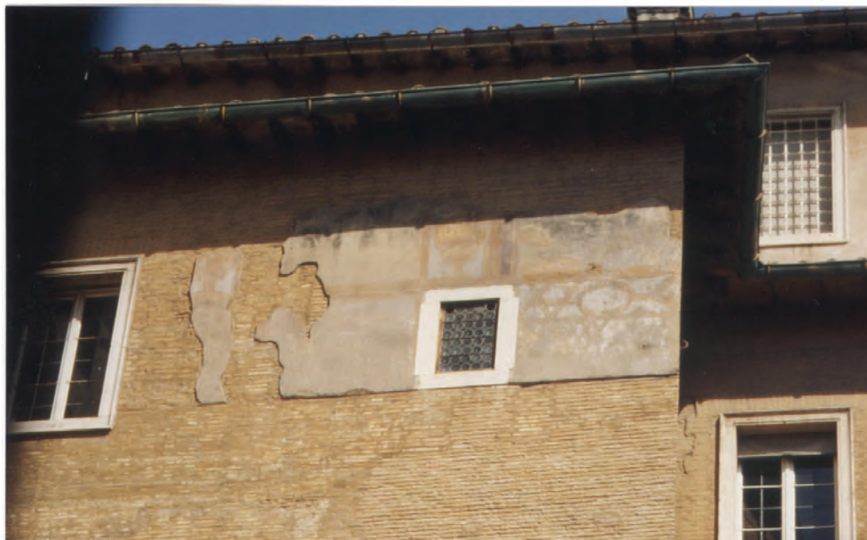
Figuur 34: Extérieur van de Stufetta van kardinaal Bibbiena, gezien vanaf de Cortile del Pappagallo. Vaticaanse apostolisch paleis (Foto september 1999)
