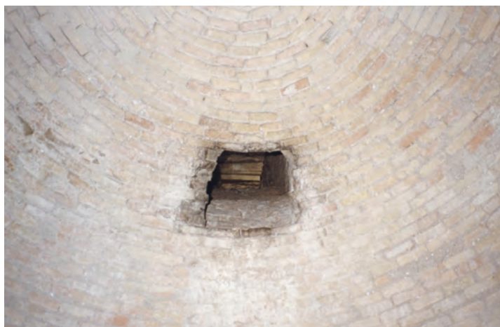
Figuur 18: Rocca di Ostia, concentrisch gemetselde bakstenen koepelgewelf met een ventilatieschacht (Foto oktober 1999)
