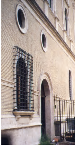
Figuur 76: Deel van de achtergevel (noordwest kant) met poort naar de tuin en de twee ronde ramen, links van de kleedkamer en rechts van de badkamer, Palazzo Riario (Foto 2007)
