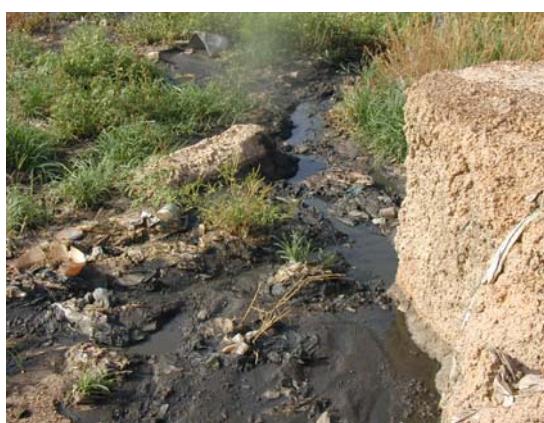
Photo 5.6 : Rejet de boues de vidange
