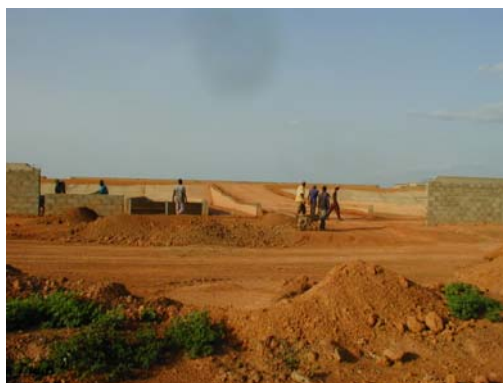
Photo 4.3 : Vue partiel de la STEP en construction
