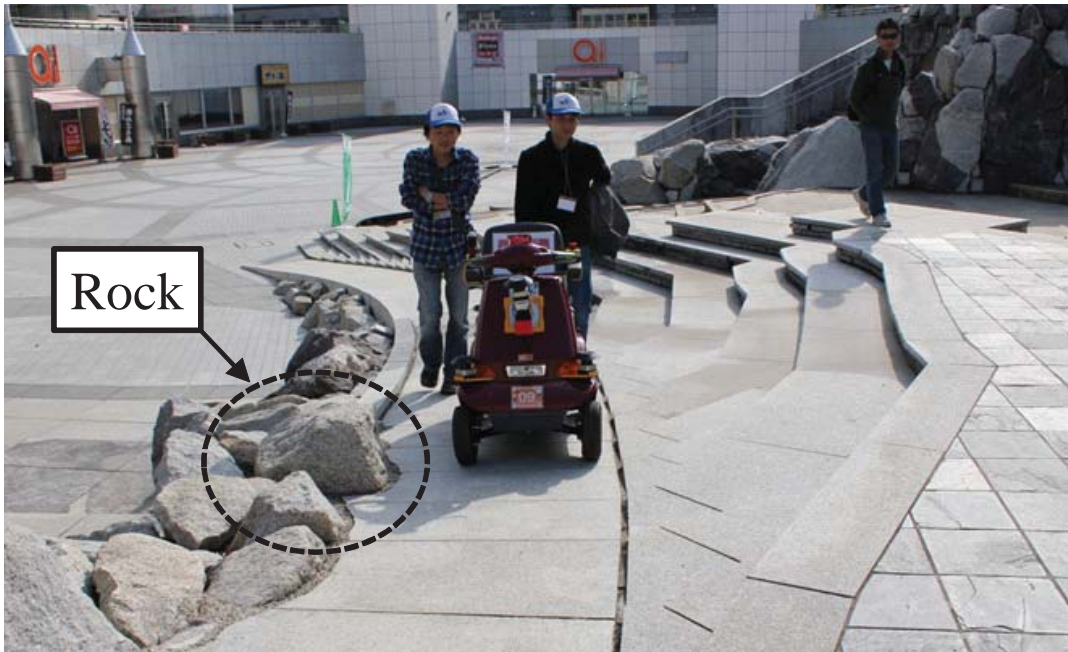
(a) スロープ中に張り出した岩
