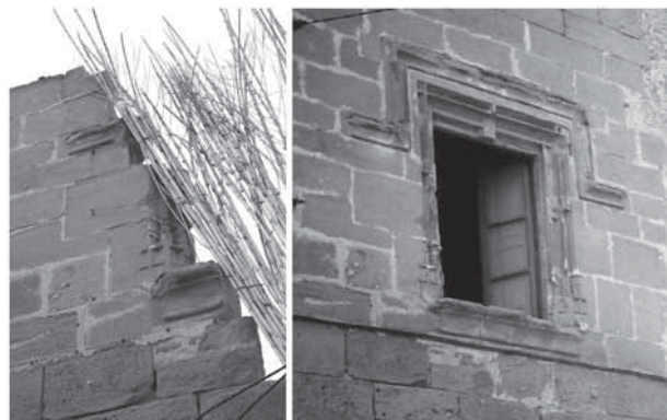
Figura 14. A l'esquerra, detall de les restes del brancal del finestral tardogòtic i, a la dreta, detall del finestral abans que fos enderrocat l'estiu de 2002 (Font: fotografia, Arxiu Barret Picat, imatge facilitada per Esteve Mestre).
